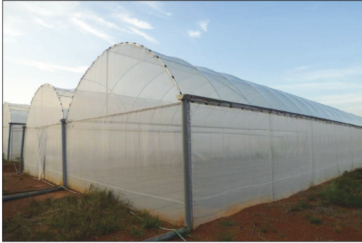
Gambar 1. Binaan struktur pelindung hujan yang boleh digunakan bagi penanaman halia secara fertigasi
