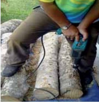
Gambar 3. Batang kayu getah yang ditebuk dengan menggunakan penebuk berkuasa elektrik untuk memudahkan kerja
