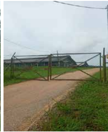
Gambar 2. Pagar perimeter pintu masuk reban
