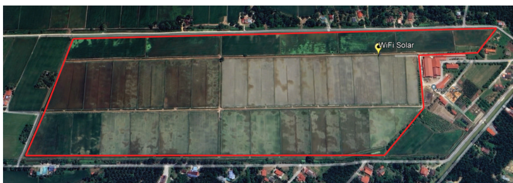
Gambar 1. Lokasi pemasangan di lapangan MARDI Parit, Perak
